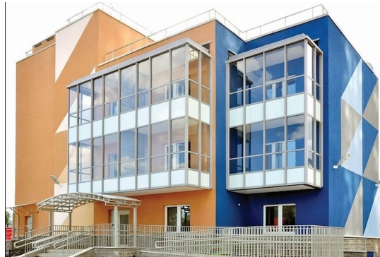
ГАООРДИ г. Санкт-Петербург, Микрорайон «Новая Охта»
